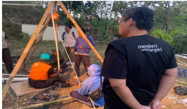
Gambar 3. Pembuatan Sumur Bor Sumber: LAZISMU Pusat (2023)
