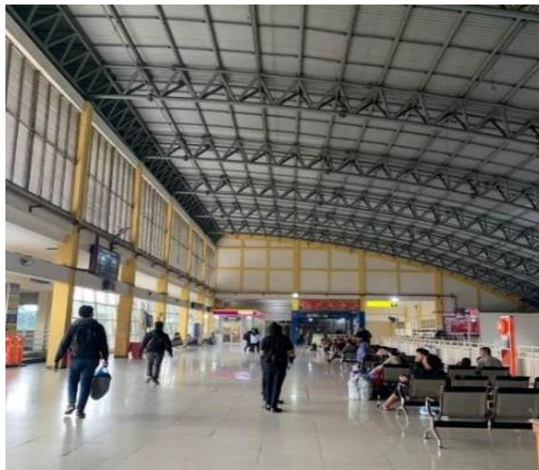
Gambar 2. Zona I Terminal Purabaya Sumber: Dokumentasi Penulis, 2025
